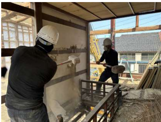
写真 3 公費解体の様子
