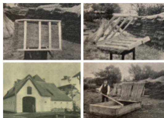
図1: ゲルネンツ屋根の製造方法 出典:参考文献7に同じ
