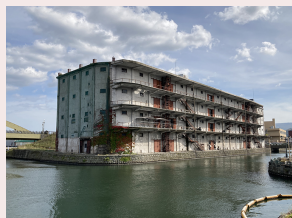
北海製罐第3倉庫
