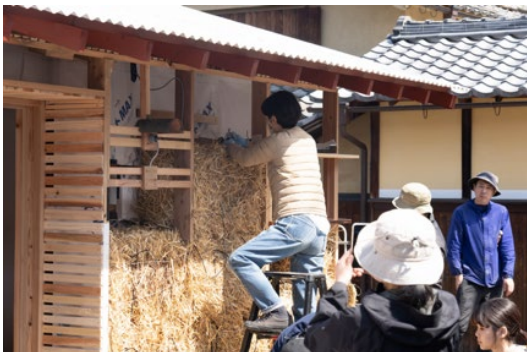
図9：ストローベイル構法による辻番所の下屋
