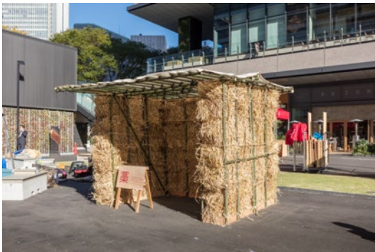
図8：ストローベイル構法による藁のタイニーハウス
