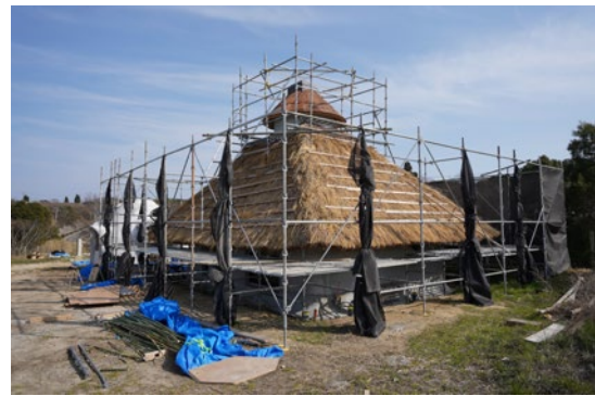
図10：ストローベイル構法による茅土庵
