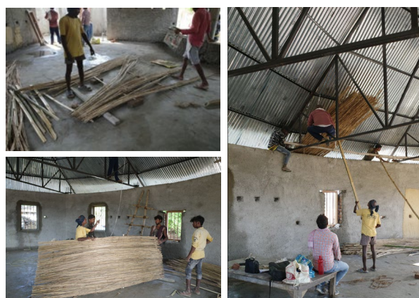
図 6：屋根下への茅パネル材の取り付けの様子
