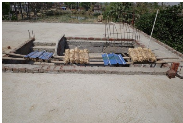
図 5：屋根材の表面温度の検証
