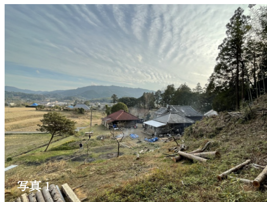
2-2:古民家「したさん」の改修
