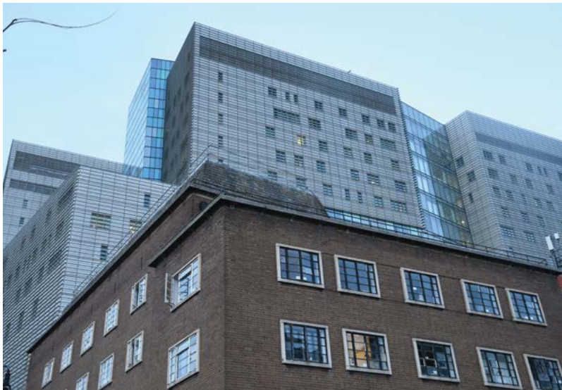
Floyer House and the adjacent Royal London Hospital in the Whitechapel area. | ホワイトチャペル地区のフロイヤー・ハウスとロイヤル・ロンドン病院。| Photograph by Casper Laing Ebbensgaard
